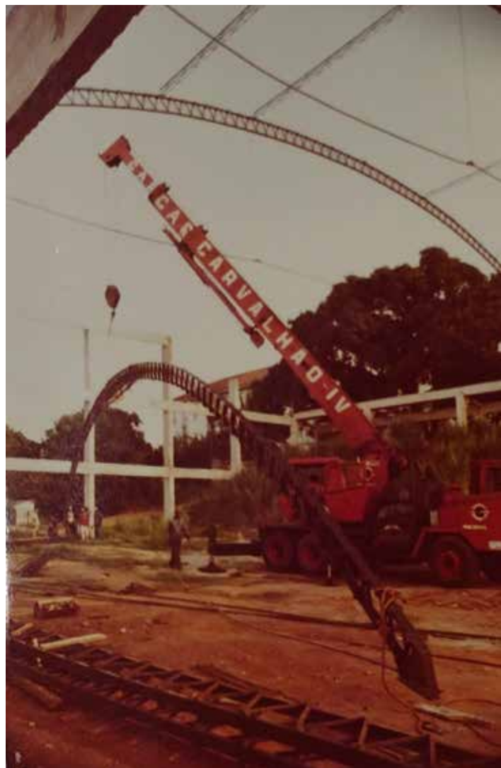
Construção do Ginásio Polivalente (Loretão).
